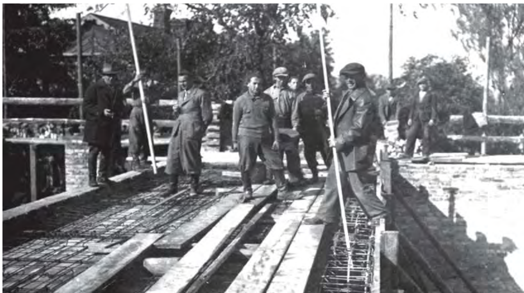
Budowa Domu Ludowego
