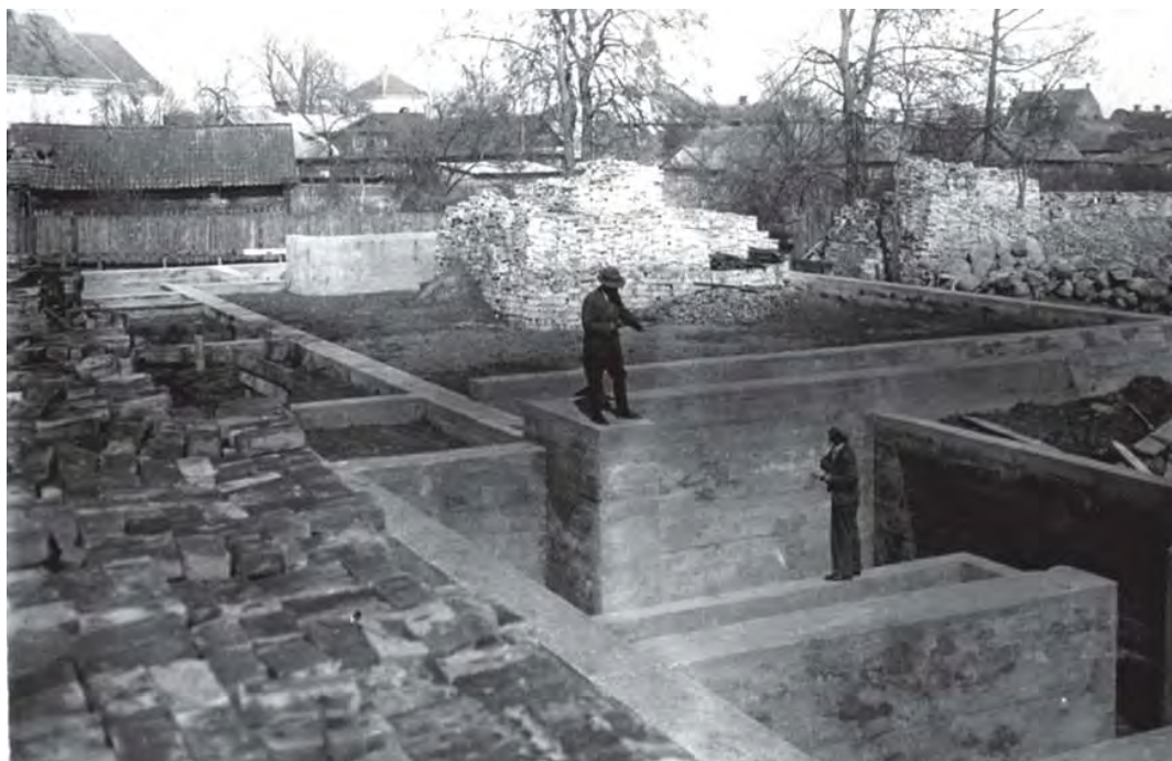
Budowa Domu Ludowego
